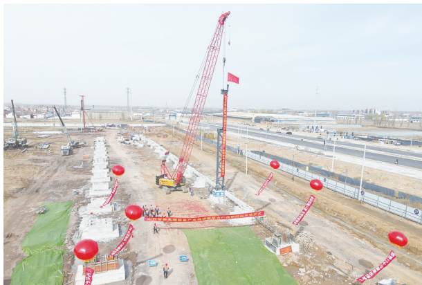
图为五标段铸锻联合厂房钢结构首吊仪式
